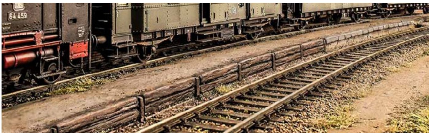
Abb.: Schüttbahnsteig 2158 mit Schwellen, hinten mit Steinkante. 2159.
